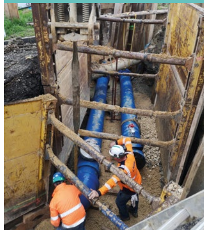
Travaux de renouvellement des canalisations d'alimentation du réservoir Bellevue
